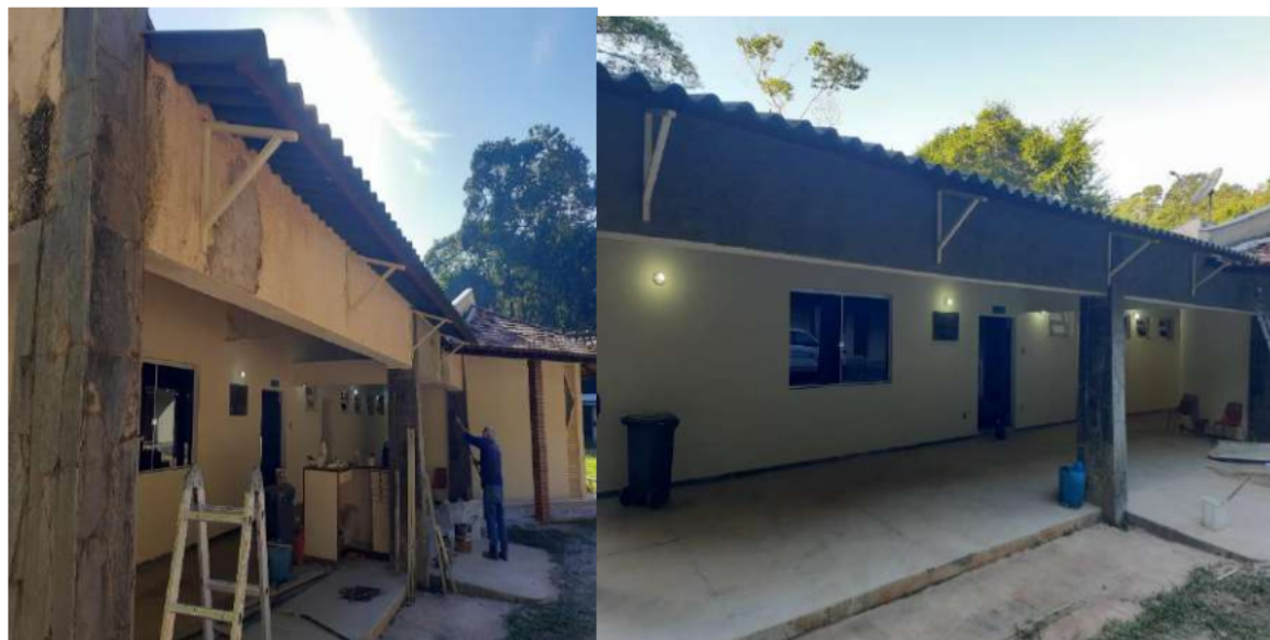
Figura 2: Sala de reunião florestal reparos nos rebocos estourados e finalização com três demãos de tinta.
