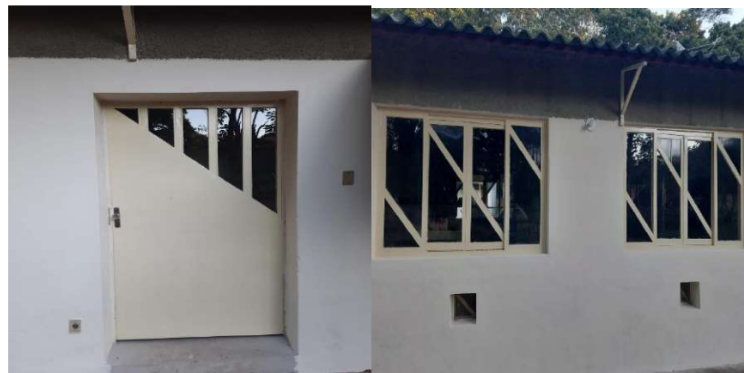
Figura 3: Viveiro sala de beneficiamento de sementes - Finalizados reparos em todo revestimento das paredes com argamassa AC2 e pinturas com três demãos de tinta em paredes, janelas e portas nas áreas internas e externas.
