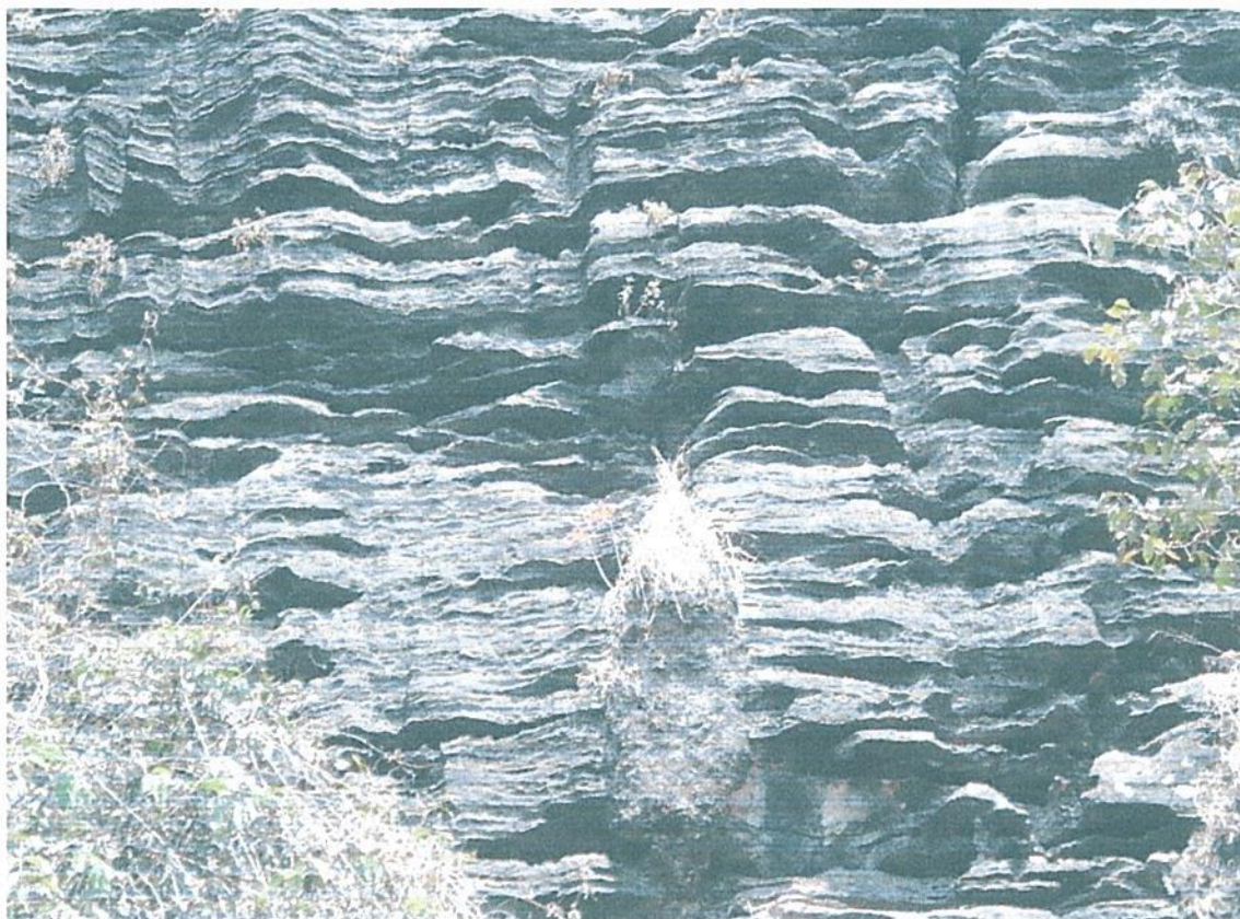
Detalhe da rocha formadora do Monumento da RPPN.
