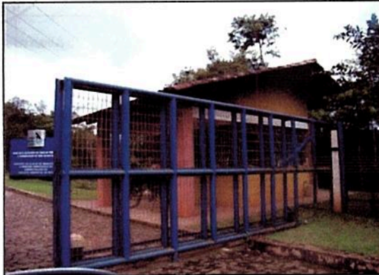
Figura 16 – Portaria e acesso principal à Estação Ambiental de Peti.
