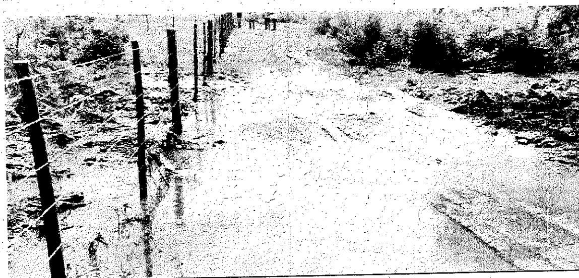
Figura 5: barramento e aterro em área de APP do córrego barreirinho
