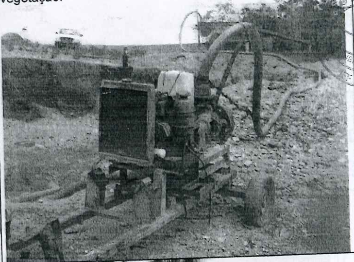
(Foto abaixo): vista parcial: 1-do motor utilizado para bombear água vinda do córrego. 2- da esteira. 3 supressão vegetação.
