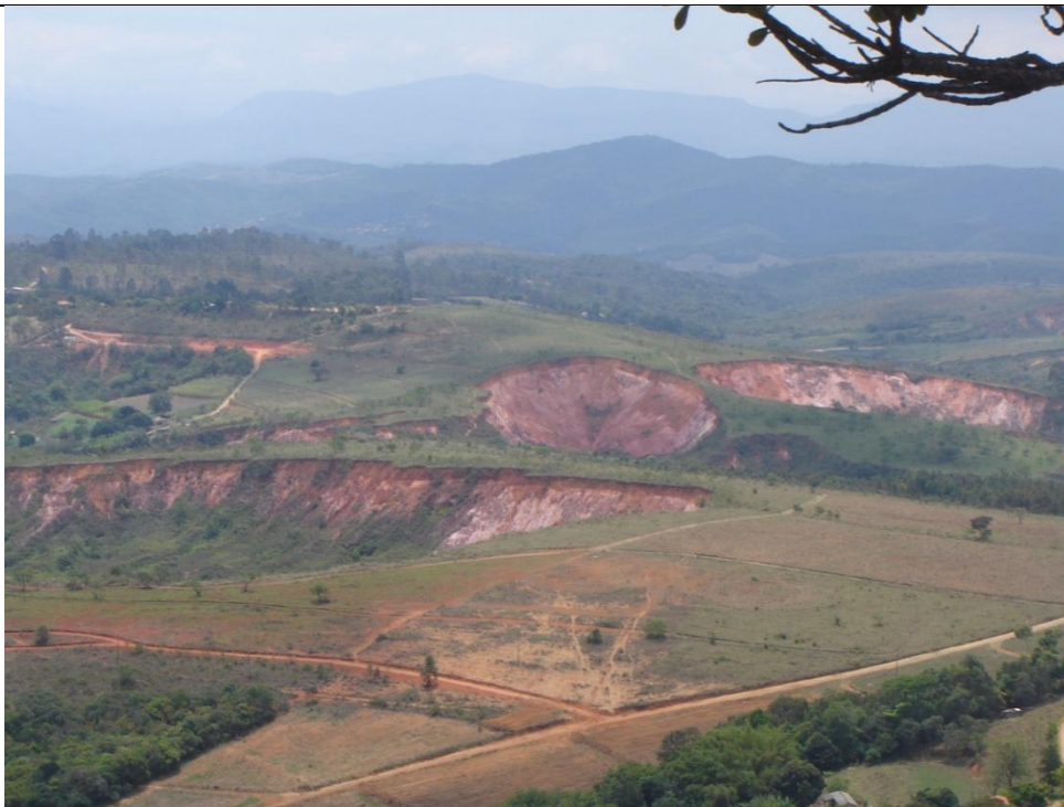
Figura 7 – Voçoroca em área de Cambissolo e Latossolo Vermelho-Amarelo.
